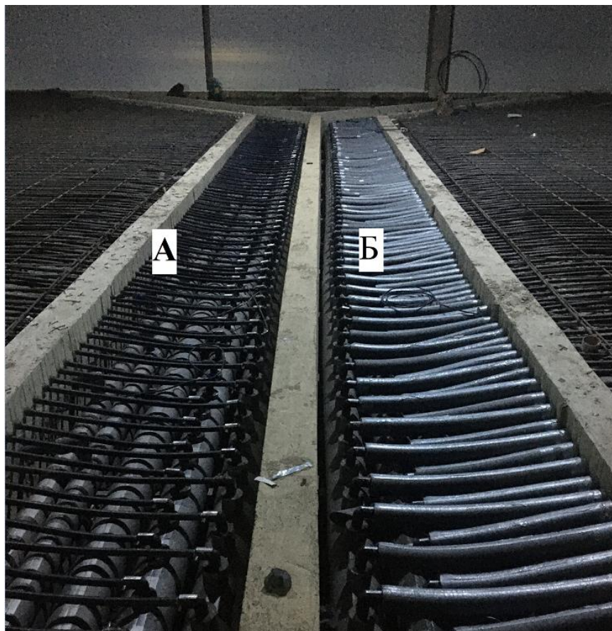
Рис. 7 – Трубопроводы в техническом канале: А - неизолированные, Б - изолированные Fig. 7 - Pipelines in the technical channel: A - uninsulated, B - isolated
