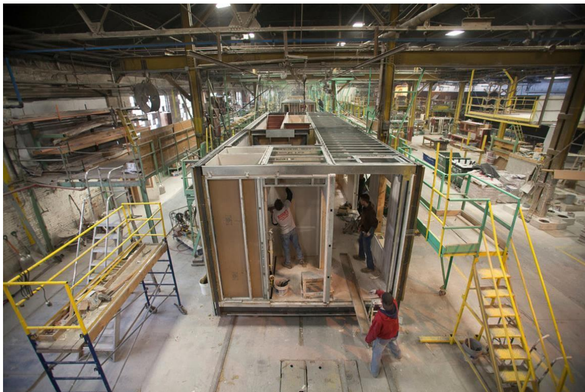
Рис. 3 - Сборка блок-модуля из легких конструкций [5].
