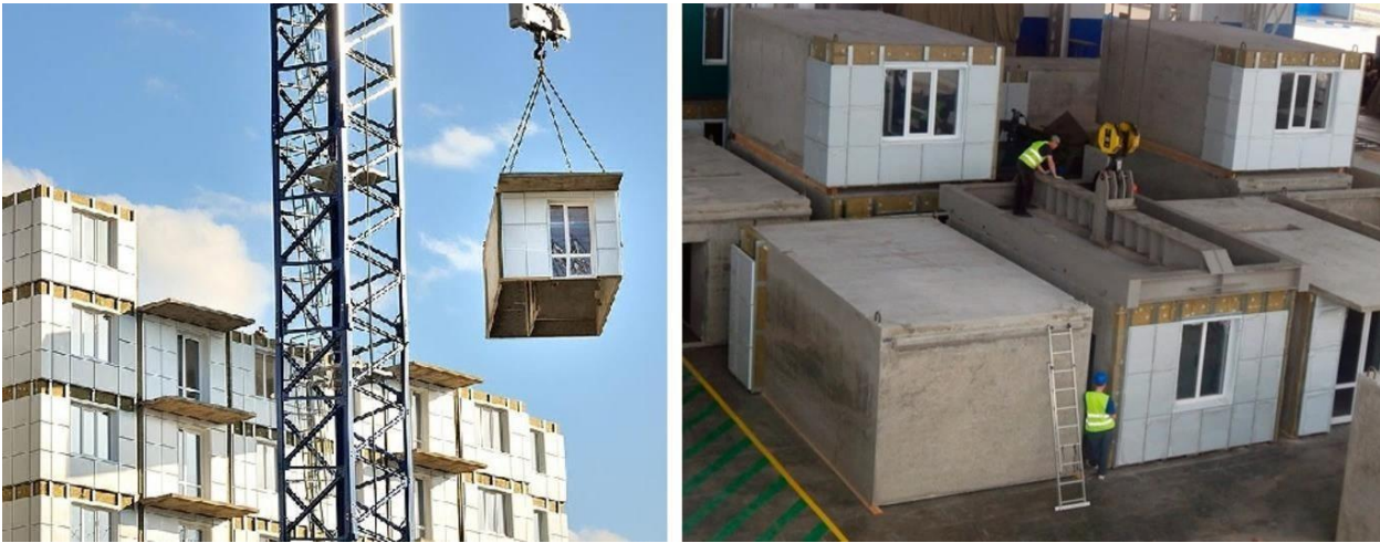
Рис. 2 - Возведение жилого дома из железобетонных ОБ производства Выбор-ОБД [5].
