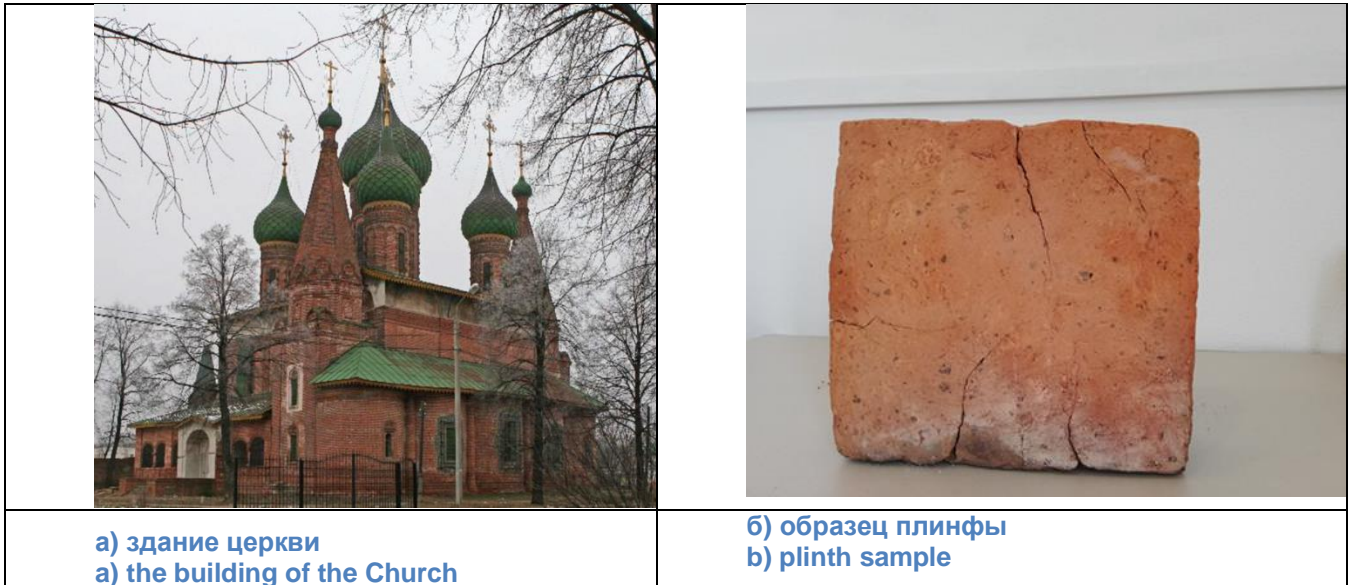
Рис. 4 - Церковь Николая Мокрого с колокольней, г. Ярославль, 1677 г. Fig. 4 - Church of St. Nicholas of the Wet with a bell tower, Yaroslavl, 1677
