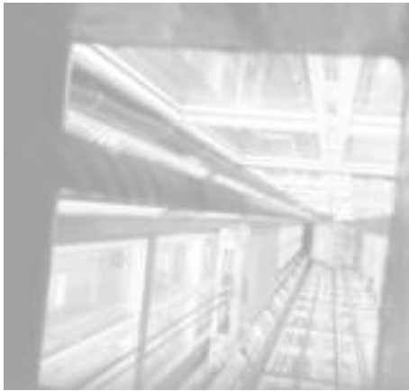
Рис. 7. Каркасно-приставная лифтовая шахта с крышей из полимерных композиционных материалов. Внутреннее состояние.
