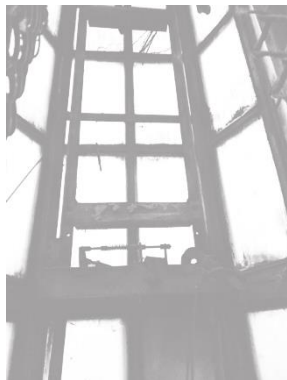
Рис. 3. Каркасно-приставная лифтовая шахта. Внутреннее состояние.
