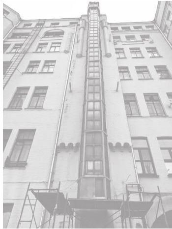
Рис. 1. Каркасно-приставная лифтовая шахта из деревянных элементов.
