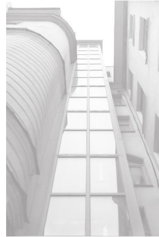
Рис. 2. Каркасно-приставная лифтовая шахта из стальных элементов.
