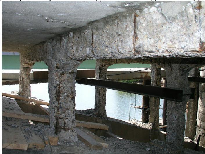
**Рисунок 1. Поврежденные мостовые конструкции [3]**
