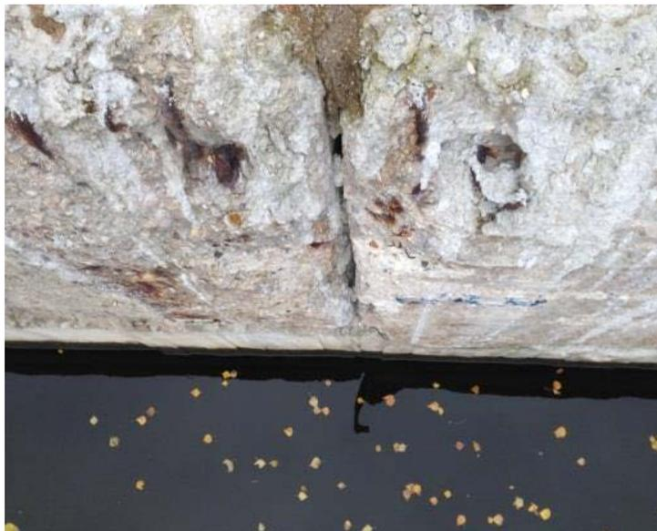
**Рисунок 3. Последствия коррозии оголовка причала[13]**
