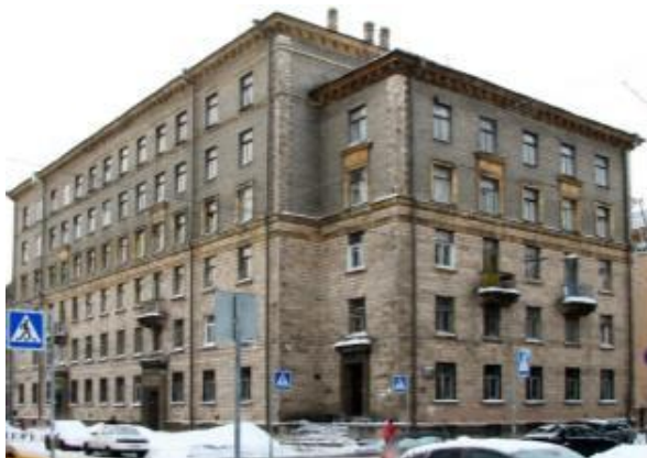
Рисунок 21. Фасад, частично покрытый декоративной плиткой.
