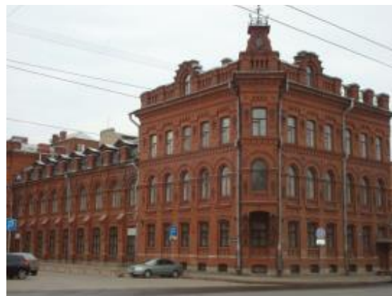
Рисунок 5. Здание без наружного штукатурного покрытия.
