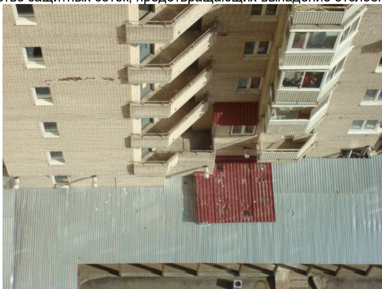
Рисунок 36. Установка защитных навесов вдоль фасада здания
