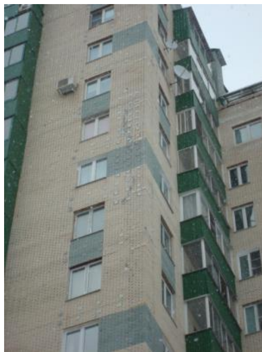
Рисунок 34. Металлические ремонтные связи.
