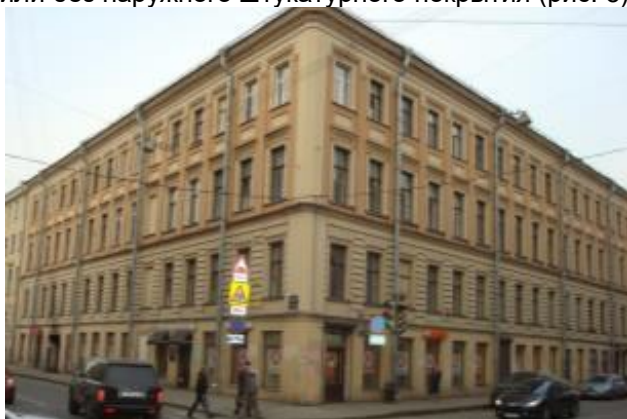
Рисунок 4. Здание с наружным штукатурным покрытием
