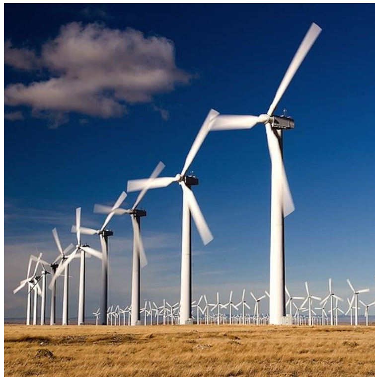
Рис. 8 Ветровые электрические турбины
