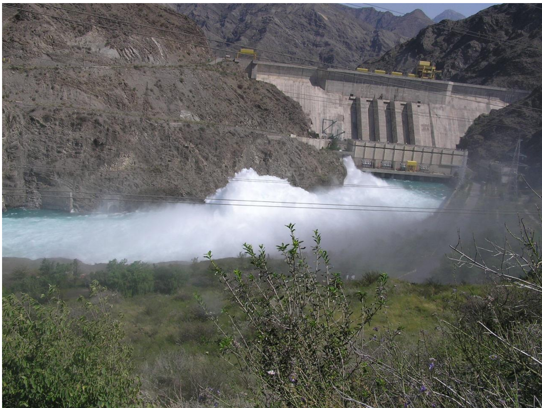
Рисунок 1. Натурные испытания поверхностного и глубинного водосбросов Курпсайской ГЭС
