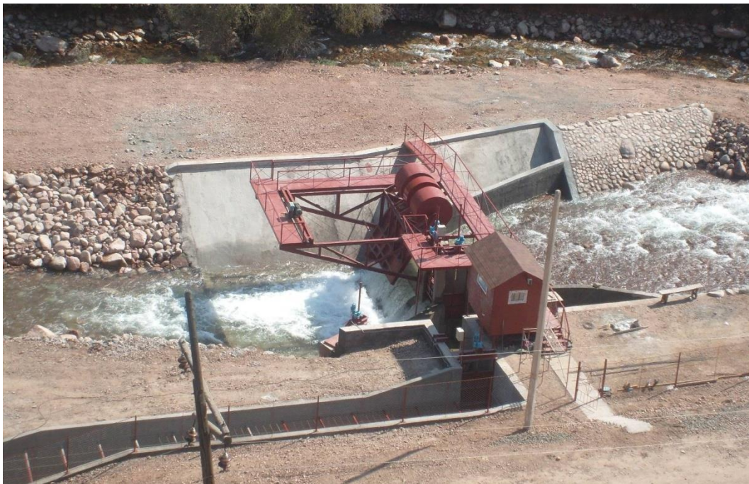
Рисунок 3. Водозаборный узел, построенный на реке Мерке (Республика Казахстан)
