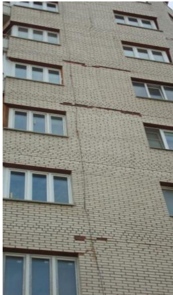
**Рисунок 32 – Повреждение облицовочного каменного слоя**
