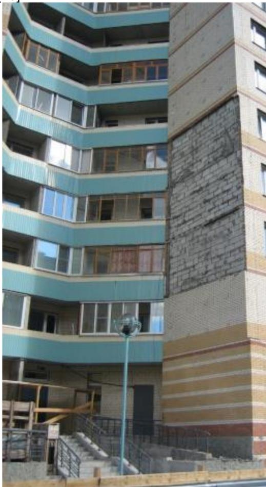
**Рисунок 31 – Обрушение облицовочного каменного слоя на строящемся объекте**
