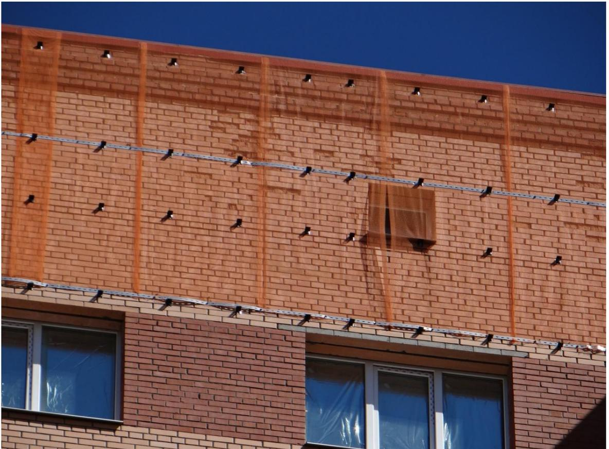
**Рисунок 35 – Устройство защитных сеток, предотвращающих выпадение отслоений лицевого
