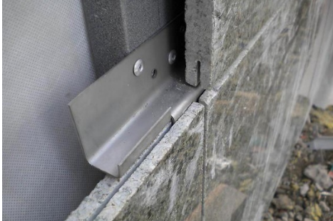
Рисунок 16 - Кляммер скрытого крепления облицовочных плит с пропилами
