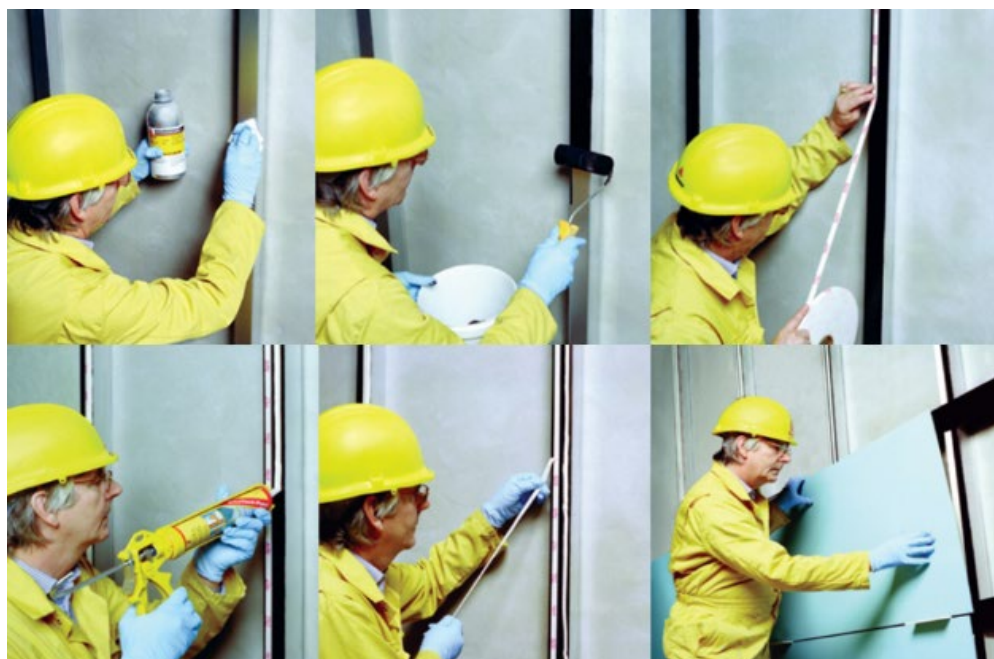
Рисунок 23 - Клеевая система для скрытого крепления
